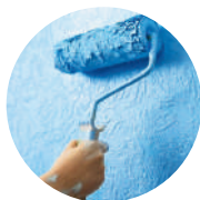
QUY TRÌNH THI CÔNG ĐƠN GIẢN, TRỰC QUAN & DỄ HIỂU
