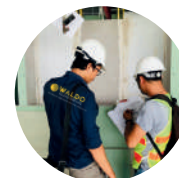
HƯỚNG DẪN THI CÔNG & XỬ LÝ KỸ THUẬT TẠI CÔNG TRÌNH
